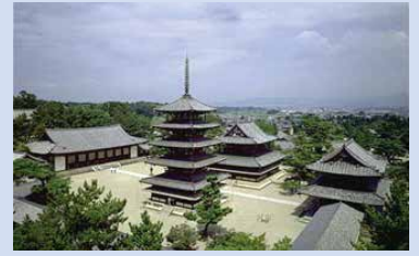
法隆寺地域の仏教建造物 (写真提供: 法隆寺)
